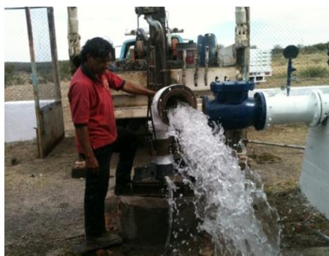
Se encuentra operando con un caudal de 27 litros por segundo, con un faltante de mantenimiento a las instalaciones con una eficiencia de 80 %.
