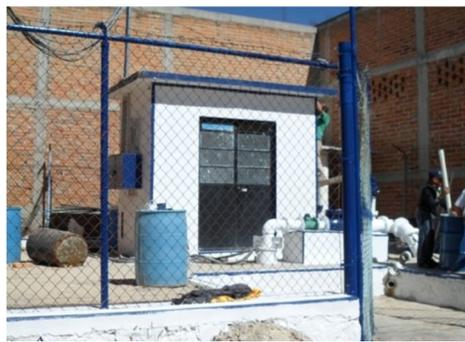
Se encuentra operando con un caudal de 46 litros por segundo, con un faltante de mantenimiento a las instalaciones con una eficiencia de 80 %.
