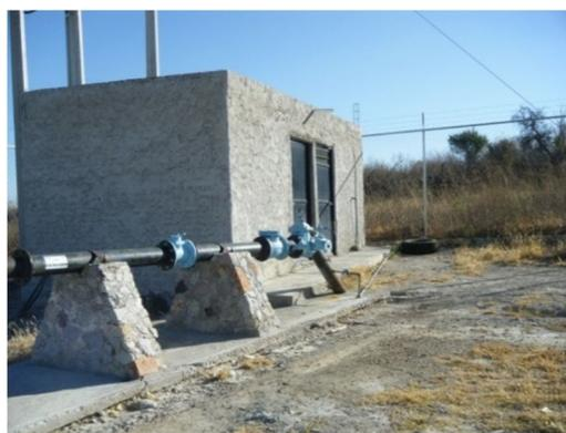
Se encuentra operando con un caudal de 24.5 litros por segundo, con un faltante de mantenimiento a las instalaciones con una eficiencia de 80 %.
