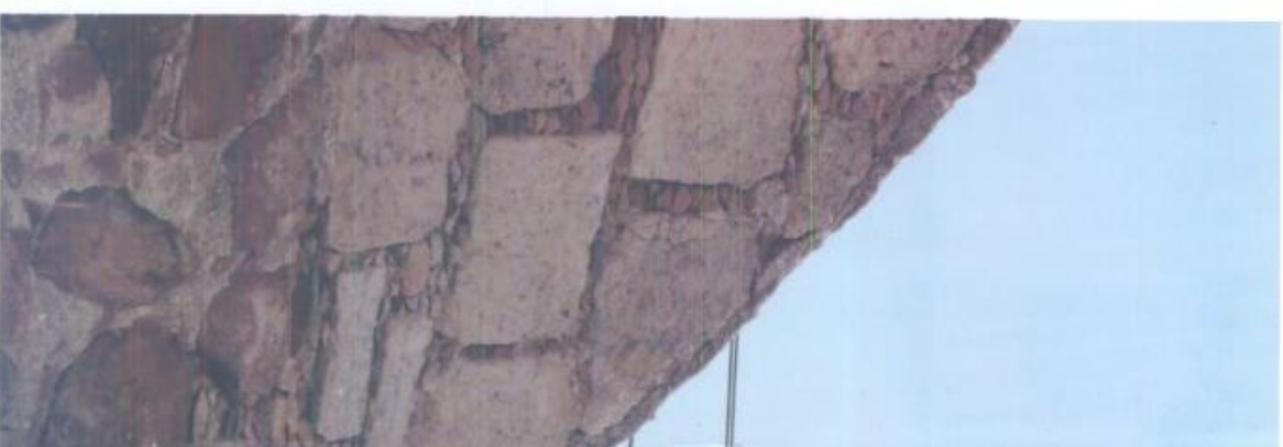
Detalle Fachada Exterior Palacio Municipal
